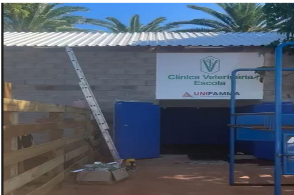
Figura 24: Construção da Clínica Veterinária Escola.
