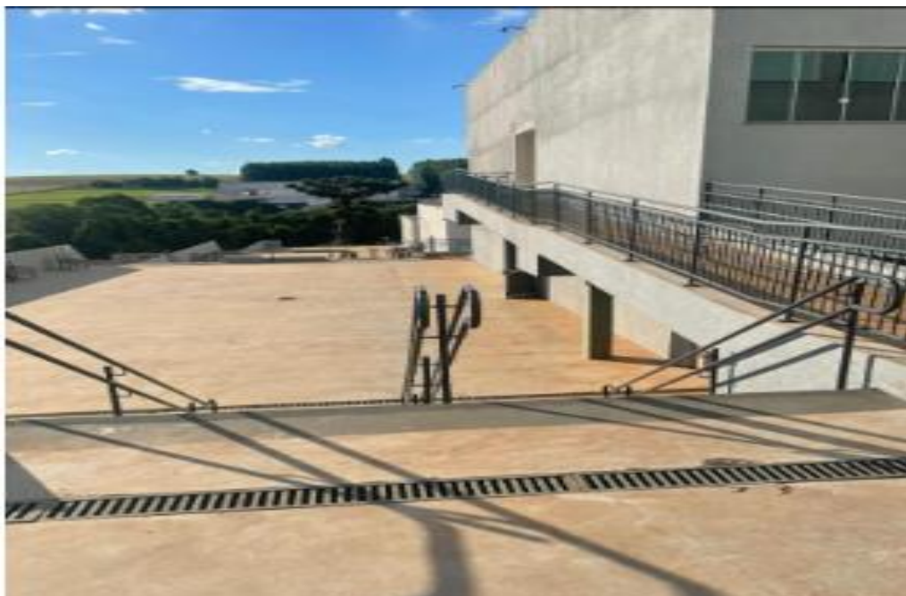
Figura 26: Instalação de corrimões nas escadarias e rampas.
